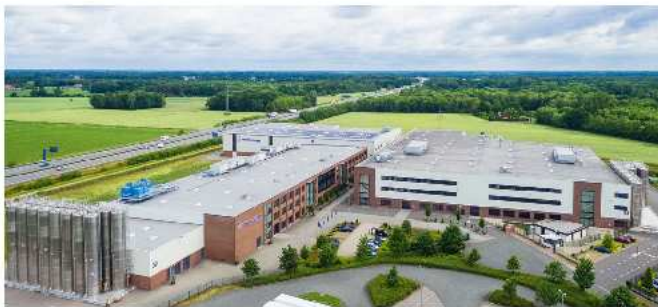
Allemagne - Usine 3 : Pöppelmann GmbH & Co. KG, Lohne/Brockdorf
