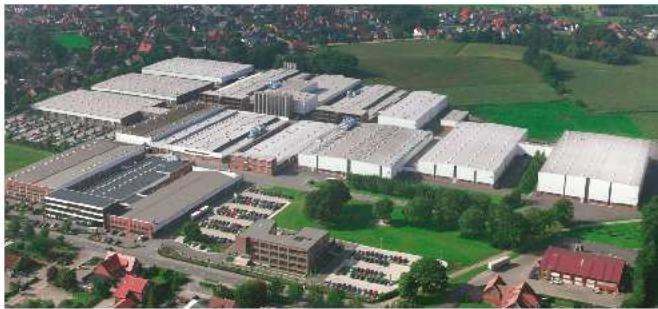
Allemagne - Usine 1 : Pöppelmann GmbH & Co. KG, Kunststoffwerk-Werkzeugbau, Lohne
