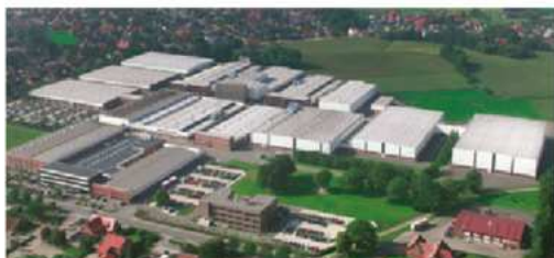
Germany, Plant 1: Pöppelmann GmbH & Co. KG, Kunststoffwerk-Werkzeugbau, Lohne
